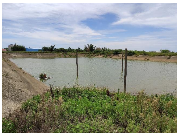
說明：堤頂道路植生情形一
