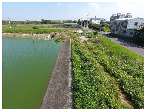
說明：堤頂道路植生情形二
